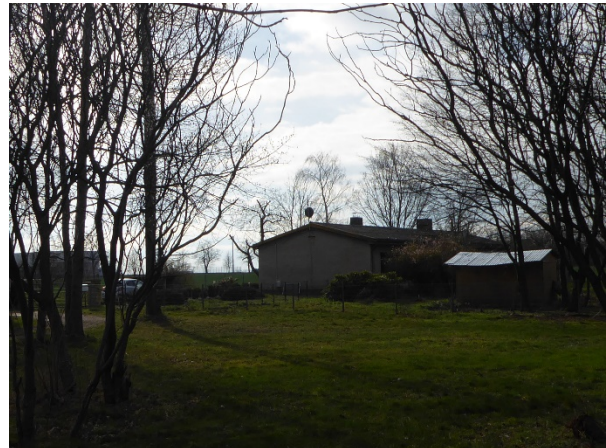
angrenzendes Wohnhaus im Außenbereich
